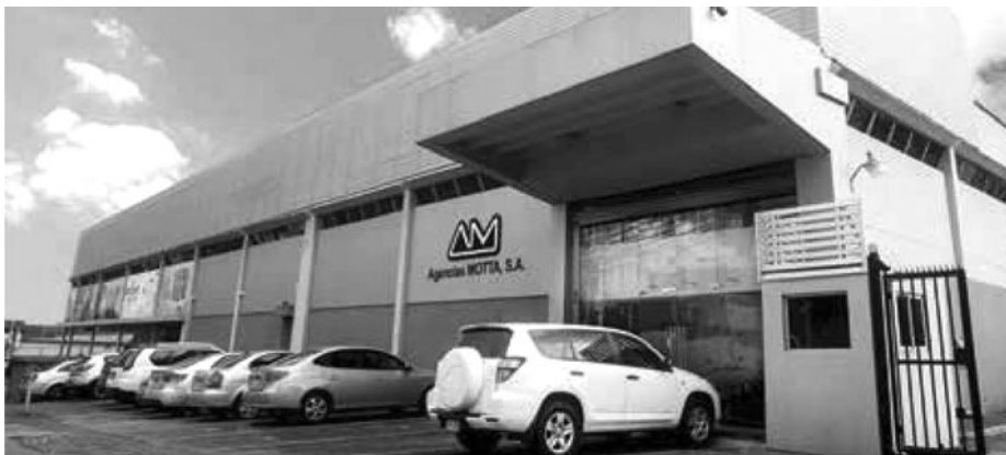
Edificio de Agencias Motta, S.A., construido en la Urbanización Industrial en 1973, sede de la empresa hasta la fecha.
