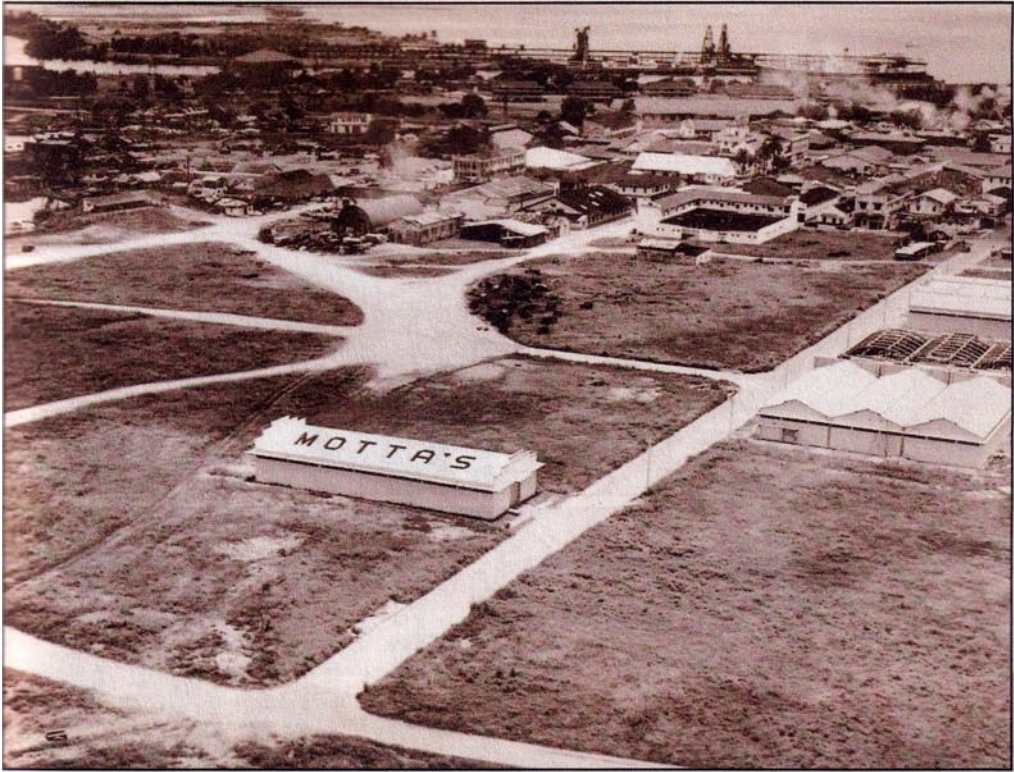
Motta's, primer almacén de depósito construido en la Zona Libre de Colón.
